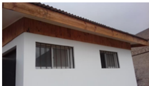
Parte de las construcciones que albergan los equipos y equipamientos del proyecto.
