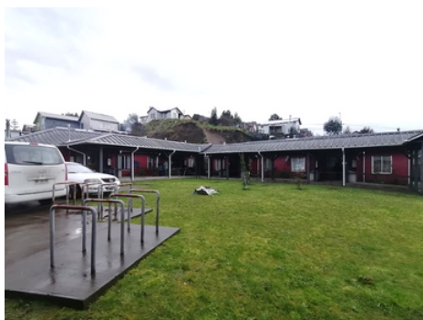
Vista general del Condominio, patio y viviendas.
