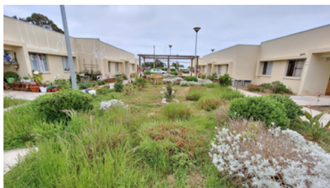
Vista general del Condominio, patio y viviendas.
