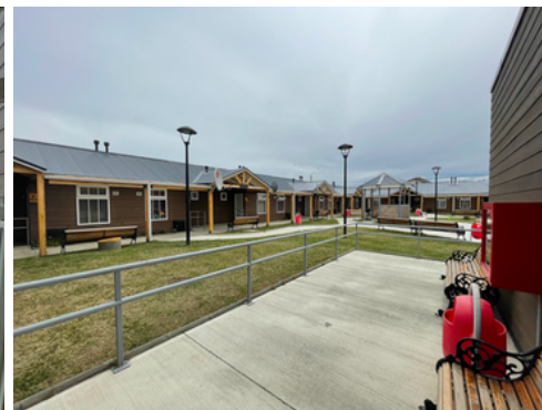
Patio central y viviendas.
