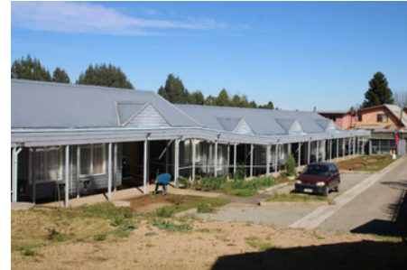
Vista general del patio central hacia los corredores de acceso a los módulos, El Carmen
