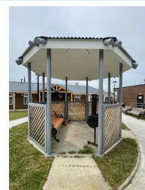
Pérgola patio centra, Punta Arenas.
