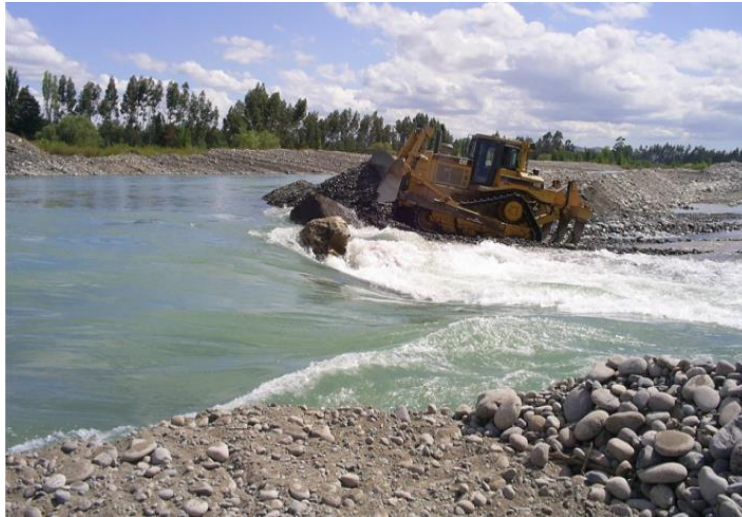
FIGURA 6. ENCAUZAMIENTO RÍO MAULE CON MAQUINARIA PESADA
