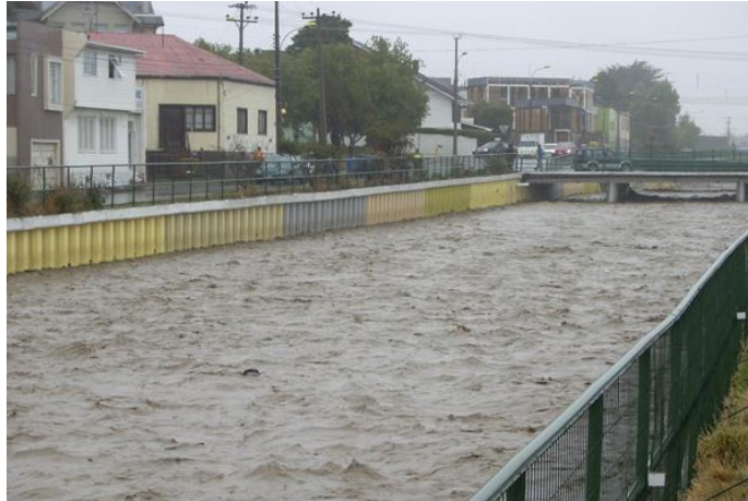
FIGURA 1. TABLESTACADO RÍO LAS MINAS
