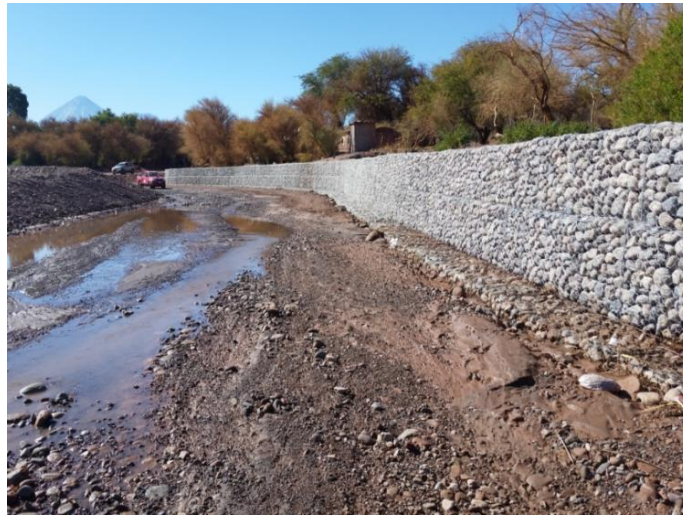
FIGURA 3. GAVIONES EN RÍO SAN PEDRO
