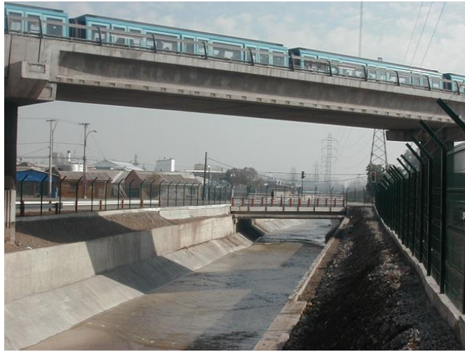
FIGURA 4. CANALIZACIÓN ZANJÓN DE LA AGUADA
