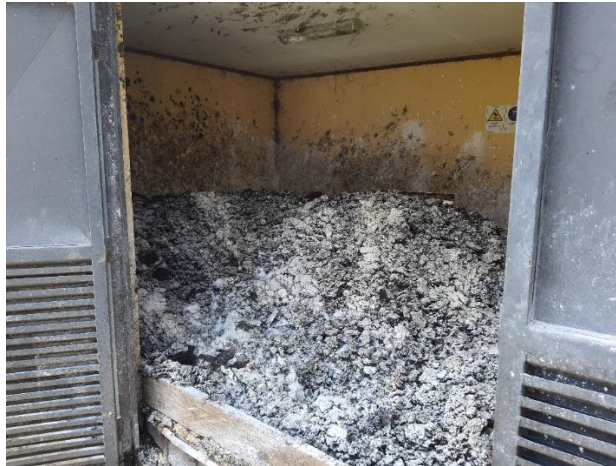
Sala de secado y acopio de lodos.
