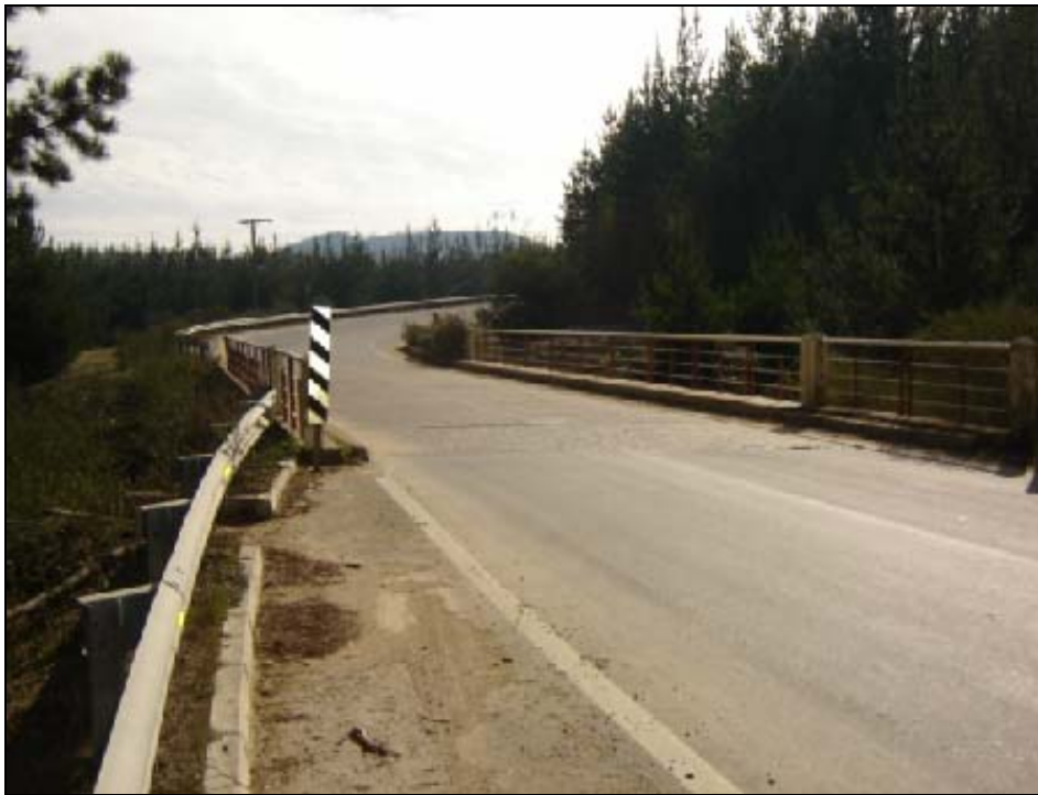
Figura 1-11: Puente Colmenares después del Proyecto
