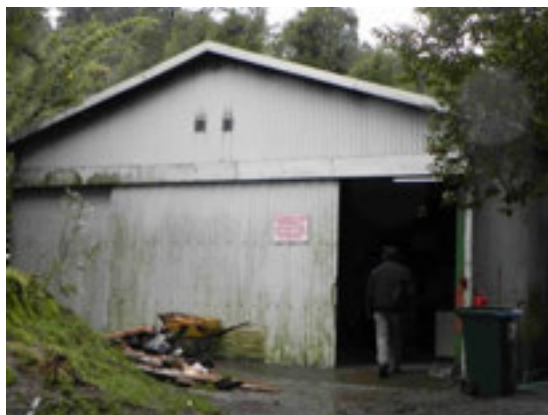
Fotografía N° 6: Sala Caldera (galpón exterior)
