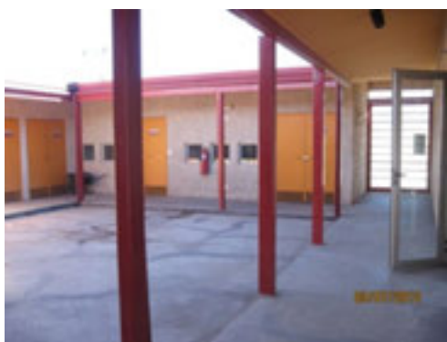
Fotografía N° 10: Patio servicio y bodegas.
