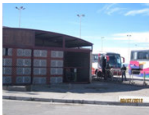
Fotografía N° 11: sala grupo electrógeno.
