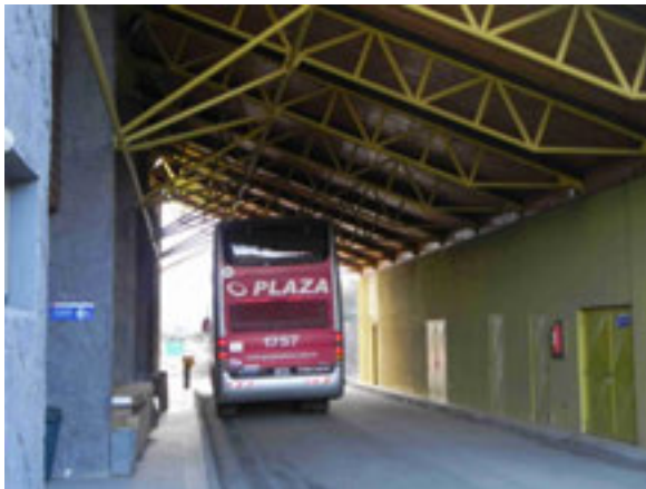
Fotografía N° 1 Losa de acceso
