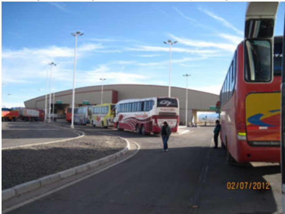
Fotografía N° 1: Vista general CF Colchane, desde las pistas de ingreso al País.
