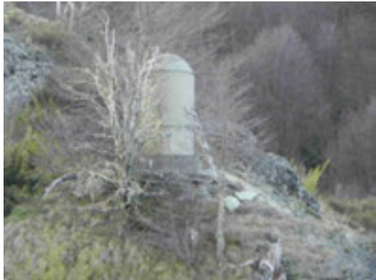
Fotografía N° 6: Estanque agua potable
