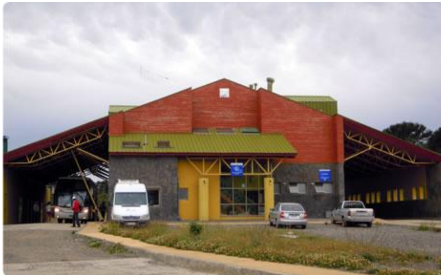
Fotografía N° 1 : Vista general CF Puesto.
