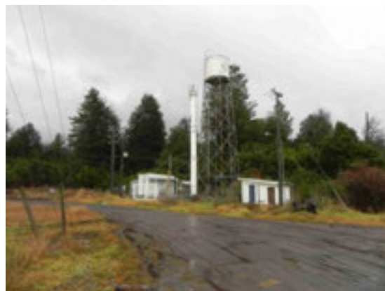
Fotografía N° 7: Estanque agua potable
