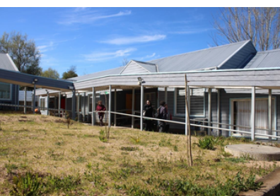
Corredor que lleva a la Sede del CVT
