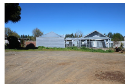
Vista exterior, fachada lateral del CVT
