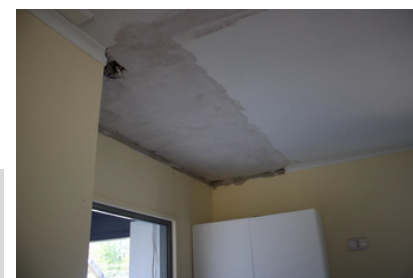
Reparación de la humedad en el cielo de un módulo
