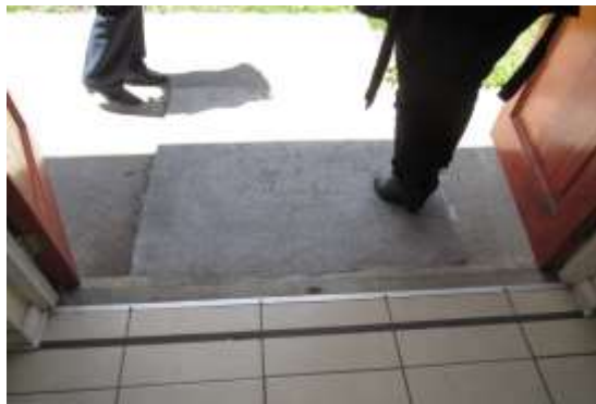
Rampa ELEM Coronel
