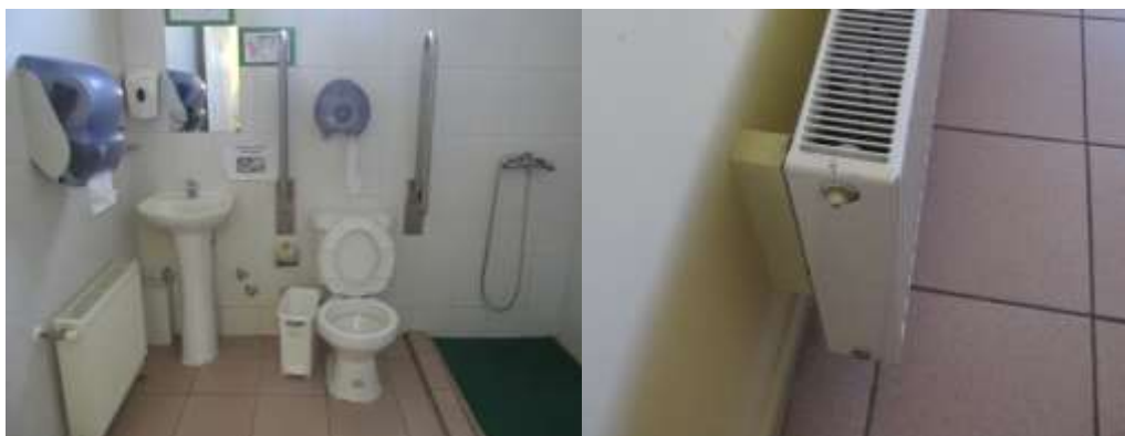
Nuevas Barras de Seguridad Empotradas a muros. Radiadores nuevamente empotrados a muros.
