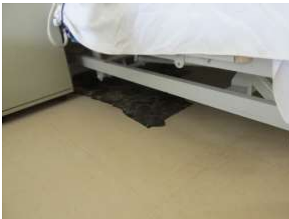
Vinílico ELEAM Licantén
