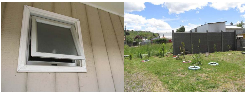
Instalaciones han debido ser aseguradas
