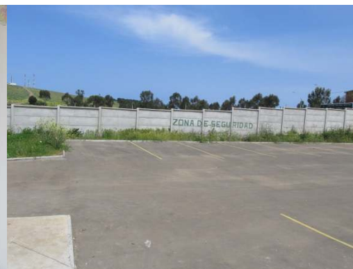
Zona de Seguridad de Condominio
