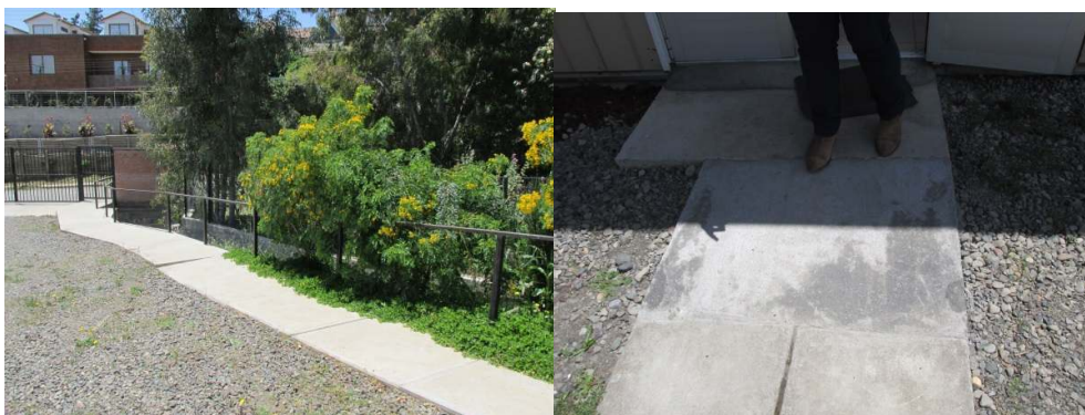
Barandas Inadecuadas. CVT La Ligua
