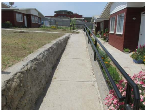
Circulaciones al interior de C.V.T.
