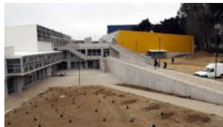
Foto N°7 Fotografía del Establecimiento.
