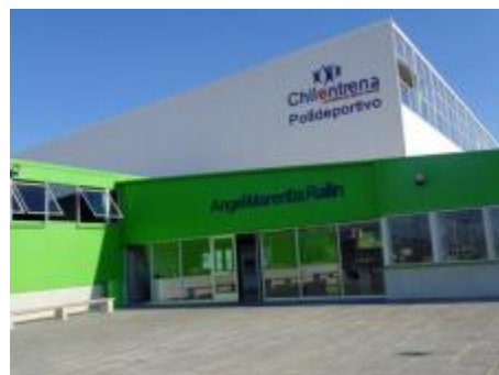
Foto N°10 Fotografía del Establecimiento.
