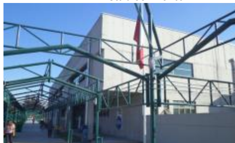
Foto N°5 Fotografía del Establecimiento.
