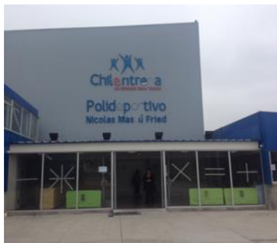
Foto N°9 Fotografía del Establecimiento.
