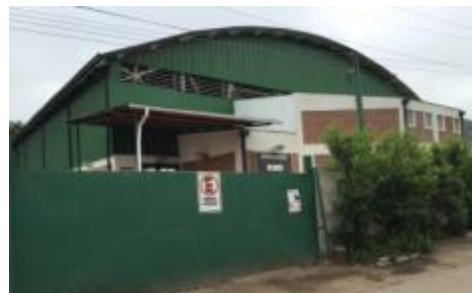
Foto N°4 Fotografía del Establecimiento.
