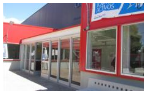
Foto N°11 Fotografía del Establecimiento.
